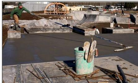
I. A continuación, se efectuará el colado del hormigón que se enrasará y compactará con una regla vibradora y/o complementada por vibradores de punta para los bordes y esquinas.
